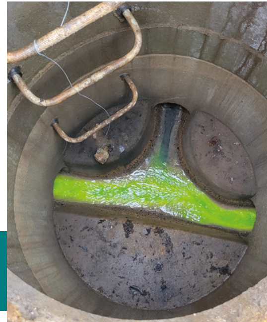
Parcours des eaux usées testé avec un colorant.
