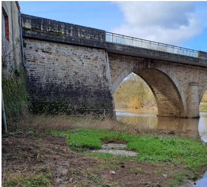
Poste de relevage actuel à Monnières
