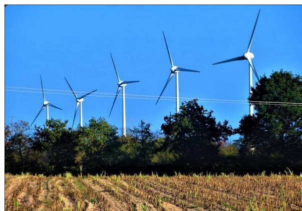
(5 des 9 éoliennes installées à Boussay)
