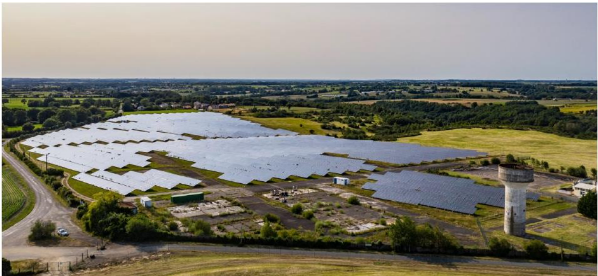
(Première centrale photovoltaïque de l'Ecarpière à Gétigné)
